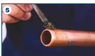
5 Tubo: decapante
