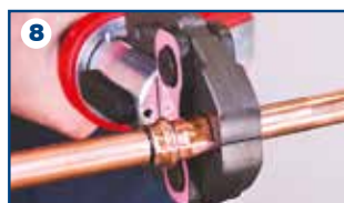
8 Completare il ciclo di pressatura. Pressare una sola volta
