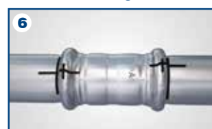
6 Marcare la giunzione completata
