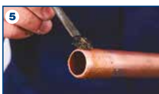
5 Tubo: decapante
