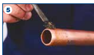
5 Tubo: decapante
