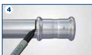
4 Contrassegnare la profondità di inserimento sul tubo tramite il misuratore di profondità
