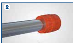
2 Sbavare ed eliminare i bordi taglienti esterni ed interni
