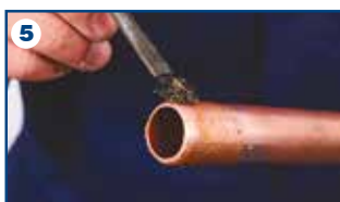
5 Tubo: decapante
