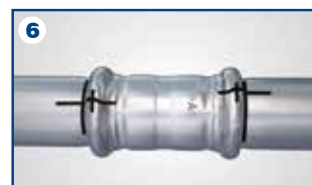
6 Marcare la giunzione completata
