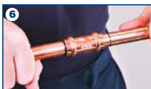
6 Inserire il tubo nel raccordo, sino alla battuta
