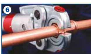
6 Allineamento delle ganasce al raccordo
