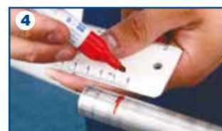
Marcatura profondità di giunzione
