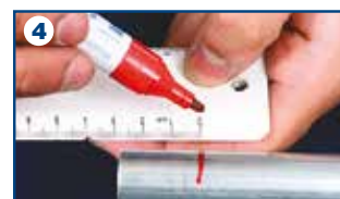
4 Marcatura profondità di giunzione
